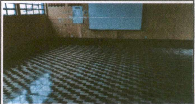
Foto 2: Sustitución de piso cerámico (aula No. 2)
