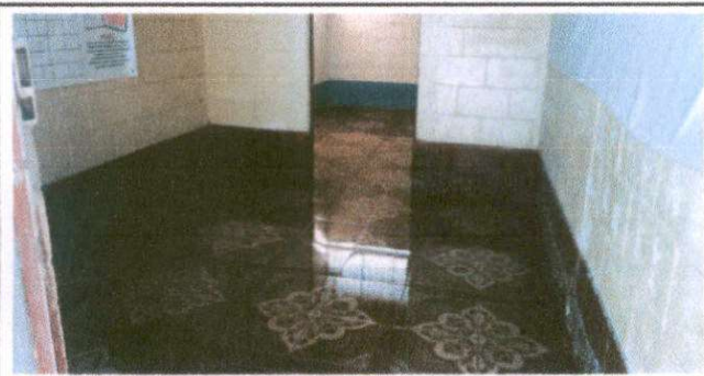
Foto 5: Sustitución de piso ceramico Dirección y bodega
