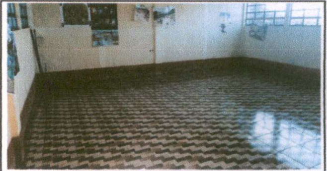
Foto 4: Sustitución de piso ceramico (aula No. 4)
